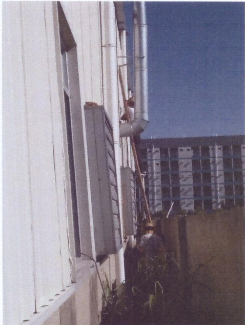
图-3 造粒废气 3 号活性炭设施出口采样
