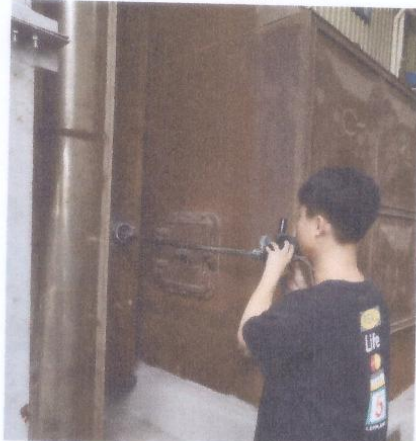
图-3 生物质锅炉布袋除尘器进口采样
